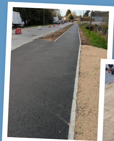
piste cyclable (chemin clos de la cave, rue de la mairie) dont les travaux sont en cours.
